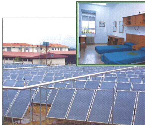
Vista general de los paneles solares de la base y detalle de una de las camaratas de los soldados.
