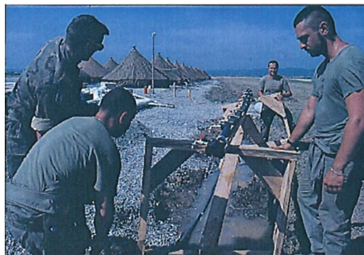
Los Ingenieros instalaron sistemas de agua por todo el campamento
