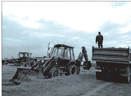
El terreno pantanoso dificultó la construcción del campamento
