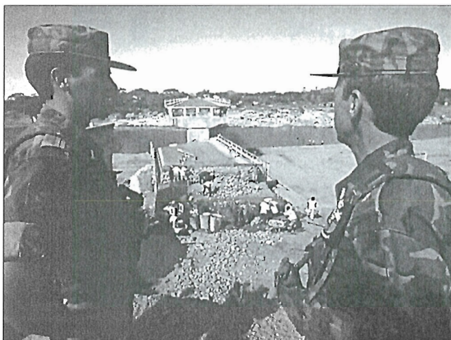
Para reconstruir la parte dañada del puente se estudió minuciosamente el terreno
