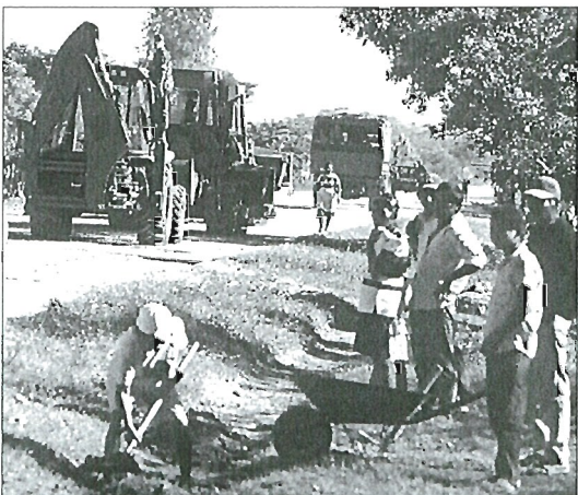
Dada la mala situación de las carreteras, su reconstrucción exige mucho trabajo
