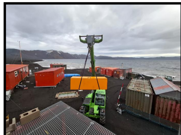
Rodrigo utilizando la MERLO para subir el armario de seguridad al nuevo módulo científico
