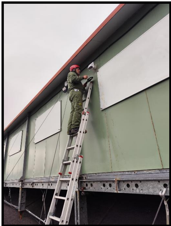
Antonio realizando actuaciones en los recuperadores de aire de las habitaciones
