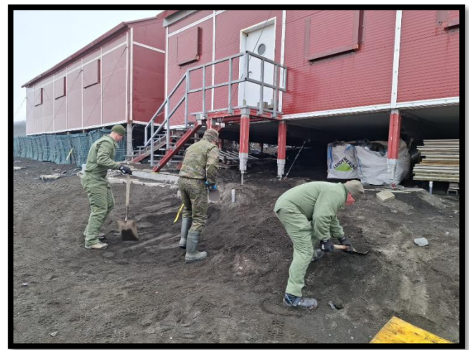
Adecuación de los vientos tras quitar las arquetas
