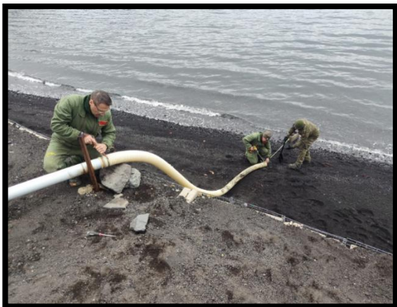
Personal del área de motores e instalaciones haciendo mantenimiento al tubo emisario
