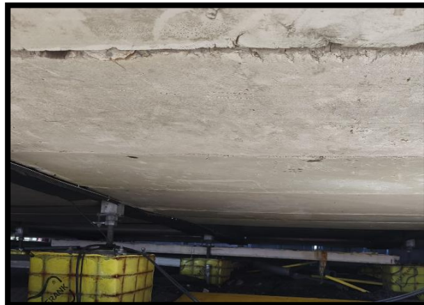
Trabajo en el suelo finalizado
