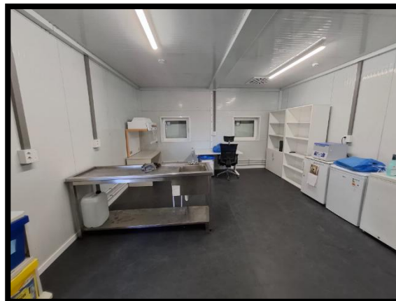
Primer mobiliario trasladado al nuevo laboratorio sucio
