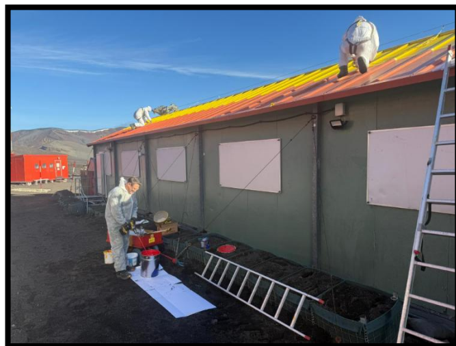
La dotación pintando el tejado del módulo dormitorio
