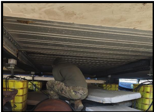
Fran colocando el suelo del taller
