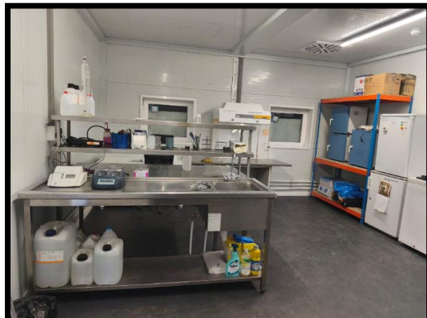
Colocación de la encimera y demás mobiliario en el laboratorio sucio
