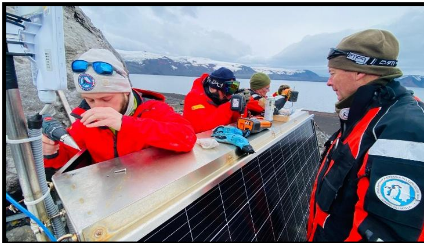
Sergio y Jorge, junto con Javier y Rodrigo instalando la estructura
