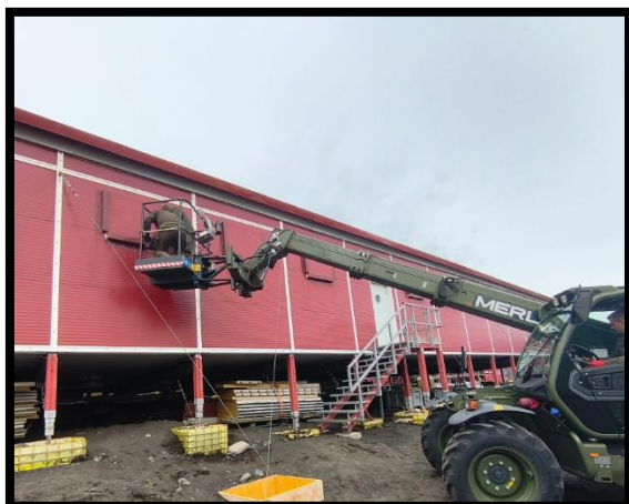
Carlos, Fran y Rubén colocando las ventanas de invernada en el módulo científico
