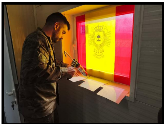
Carlos dando silicona a las señales contra incendios
