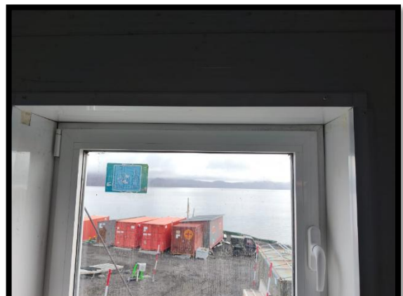
Sellado de las ventanas para mantener la climatización
