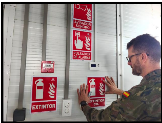
Jorge colocando las señales contra incendios
