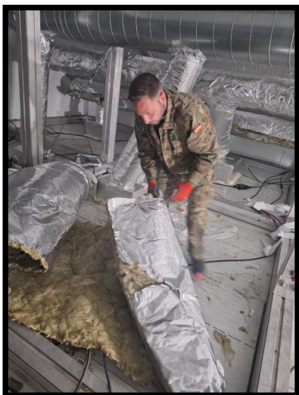
Ernesto preparando la lana de roca
