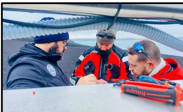
Sergio y Jorge, junto con Rodrigo realizando las conexiones eléctricas
