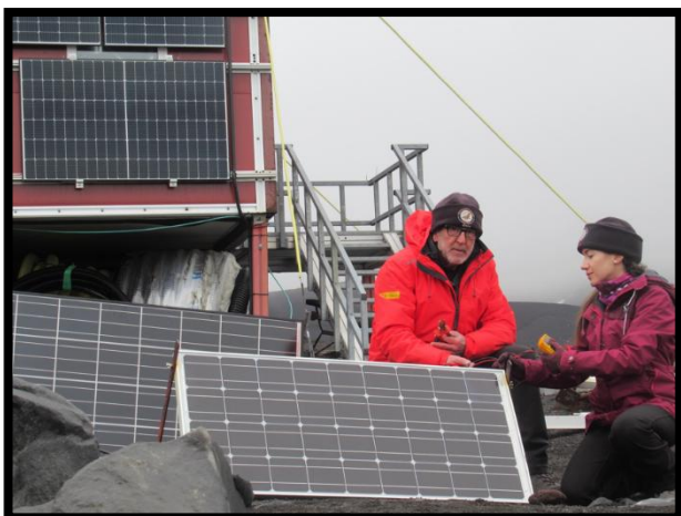
Amós y Belén reforzando las conexiones del panel
