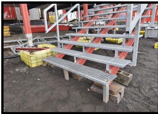
Resultado del peldaño de la escalera de botiquín
