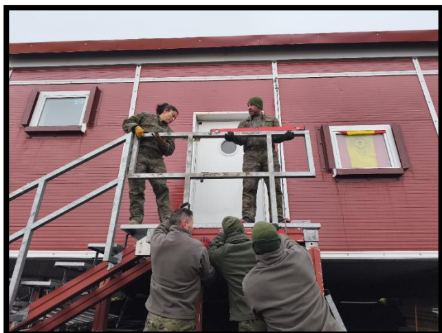
La Unidad montando las barandillas de las escaleras
