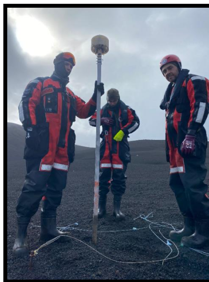
Pablo, Miguel Ángel e Ignacio cavando para sustituir el poste
