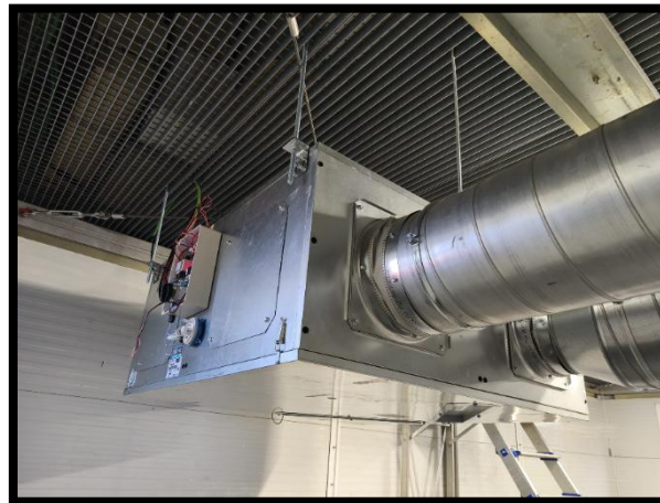
Conexiones para programar el recuperador
