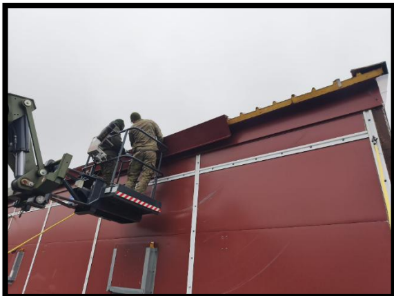
Colocación de perfil metálico en talleres
