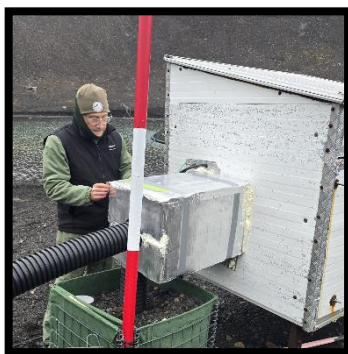
Antonio instalando la caja aislante de la bomba
