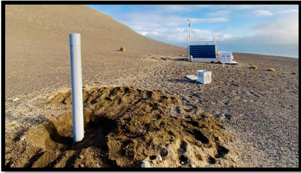
El tubo de PVC ya está posicionado
