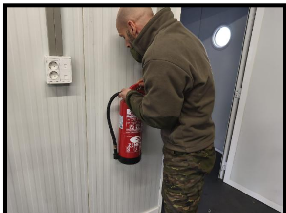
Fran colocando los extintores según normativa
