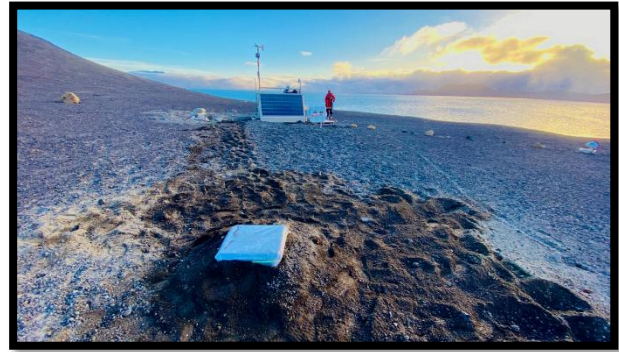
Estado final de la instalación
