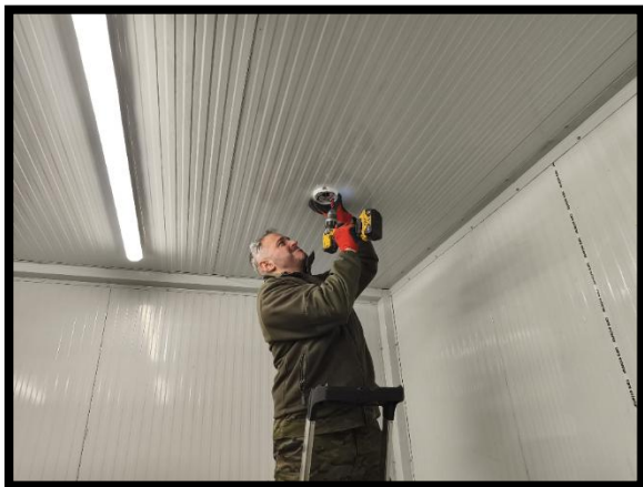
Ruben haciendo los agujeros para el paso del cableado y colocación de rociadores
