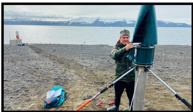
Fidel instalando el aerogenerador en Bahía Fumarolas
