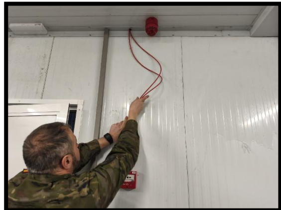
Rubén colocando pulsadores y alarmas del sistema C/I
