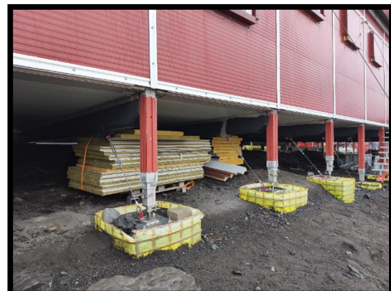
Limpeza y recogida del material sobrante
