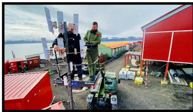
Jorge y Rodrigo instalando las antenas
