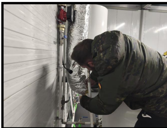
Ernesto instalando la chimenea provisional en la caldera del sistema de climatización
