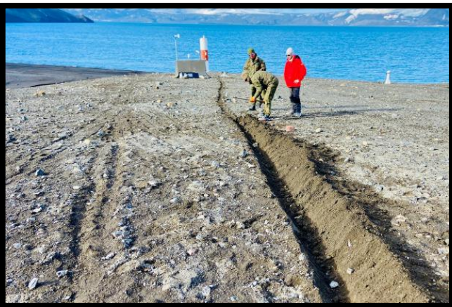
Antonio, Javier Prados y Sergio realizando una zanja para enterrar el cable que une el aerogenerador con el regulador
