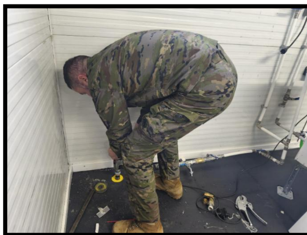
Jesús realizando el agujero para la evacuación del agua de la caldera
