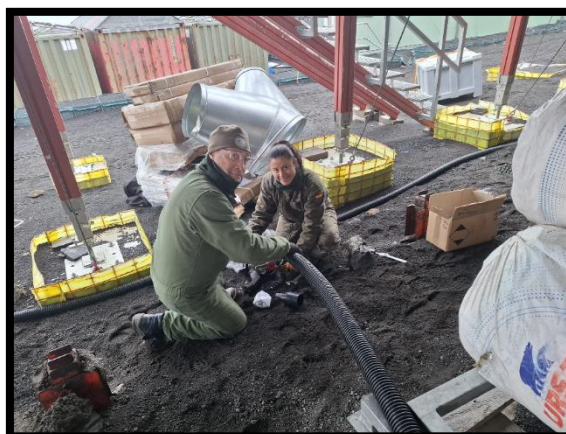
Antonio y Michelle instalando la toma de agua del nuevo módulo científico
