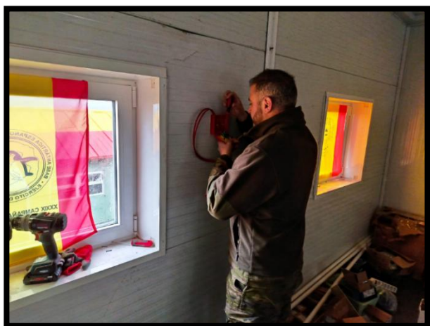
Rubén colocando los pulsadores contra incendios
