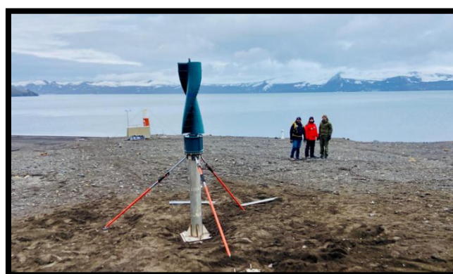
Instalación definitiva del aerogenerador
