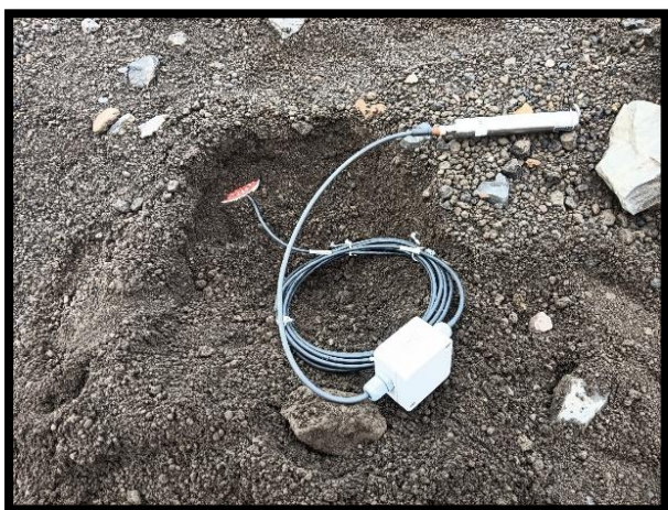
Instalación de un sensor de flujo térmico superficial en la estación Cerro Caliente
