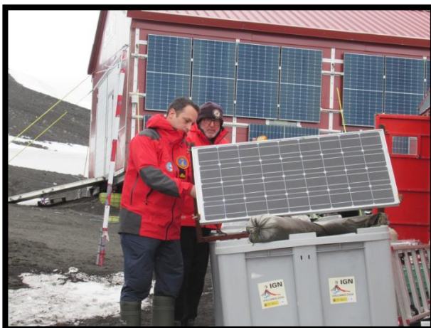
David y Amós reparando las conexiones de un panel solar
