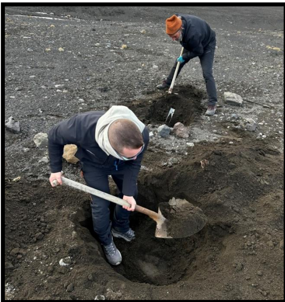
Rafa y Sergio haciendo la excavación de la cimentación en Fumarolas
