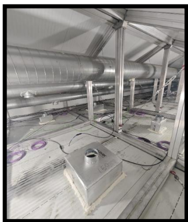
Plenum de difusores y rejillas colocados en el bajo cubierta
