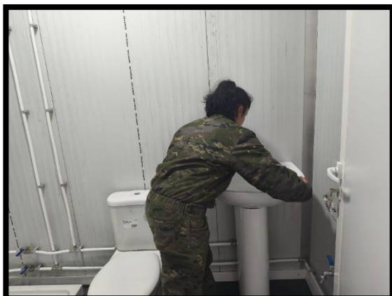
Michelle instalando el lavabo del aseo
