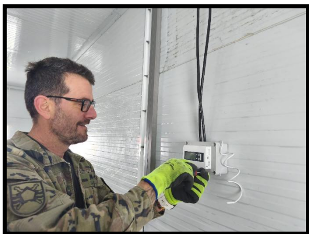
Jorge colocando el termostato general de calefacción
