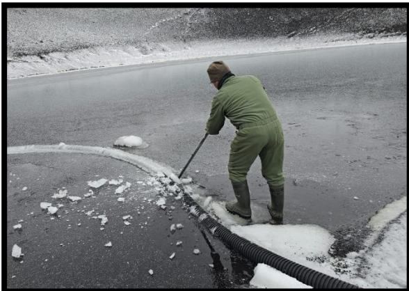
Antonio restableciendo el suministro de agua a la BAE GdC
