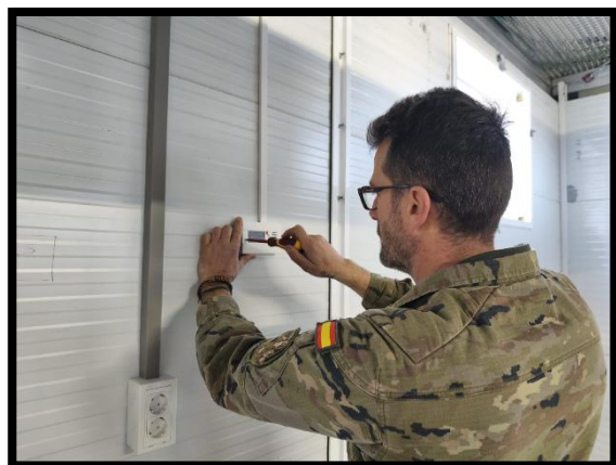
Jorge colocando el termostato del recuperador
