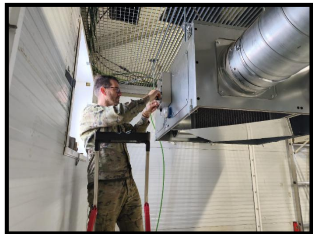
Jorge conectando el termostato del recuperador
