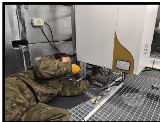
Michelle preparando el sistema de evacuación del humidificador
