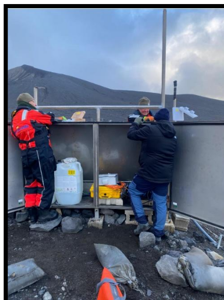
Antonio, Fidel y Jorge instalando la infraestructura en la estación OBS
