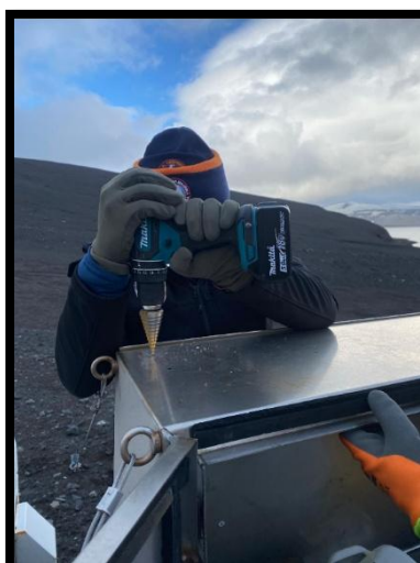
Jorge taladrando la estación para atornillar la infraestructura
