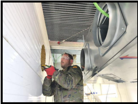
Ernesto preparando el recuperador para colocar la resistencia
