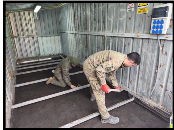
Carlos y Fran nivelando el terreno de la gasolinera
