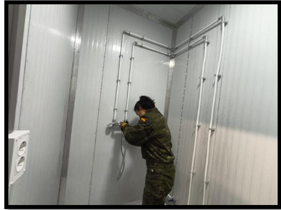
Michelle instalando el grifo de la ducha del aseo
