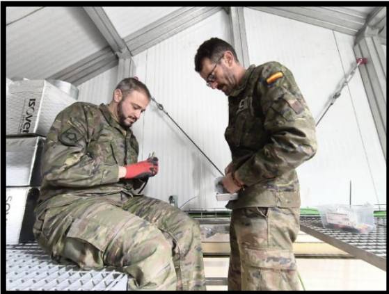
Rubén y Jorge conectando los cables del fan coil y recuperador en el cuadro eléctrico
