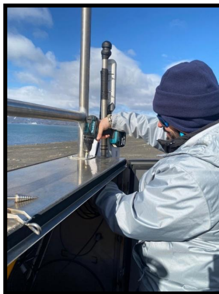
Jorge en estación Base terminando la instalación de la infraestructura para implementación de la meteo y la cámara
