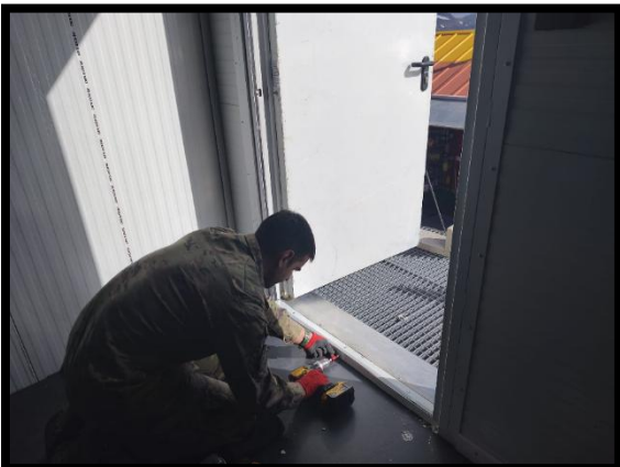
Carlos rematando la puerta exterior del almacén
