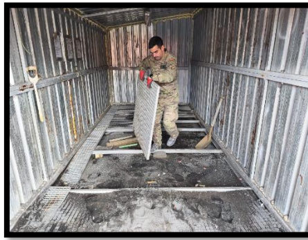
Carlos retirando el tramex de la gasolinera para su remodelación
