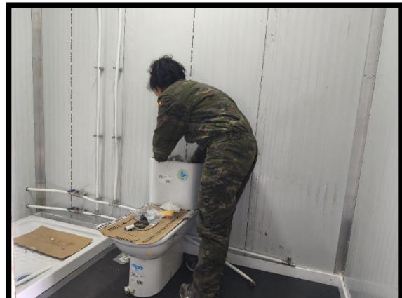
Michelle instalando el inodoro en el aseo
