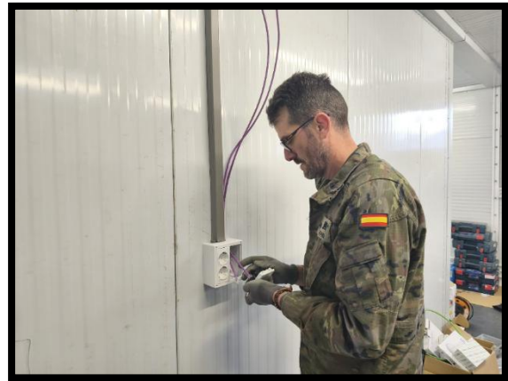
Jorge haciendo la conexión de la toma de datos en los diferentes laboratorios
