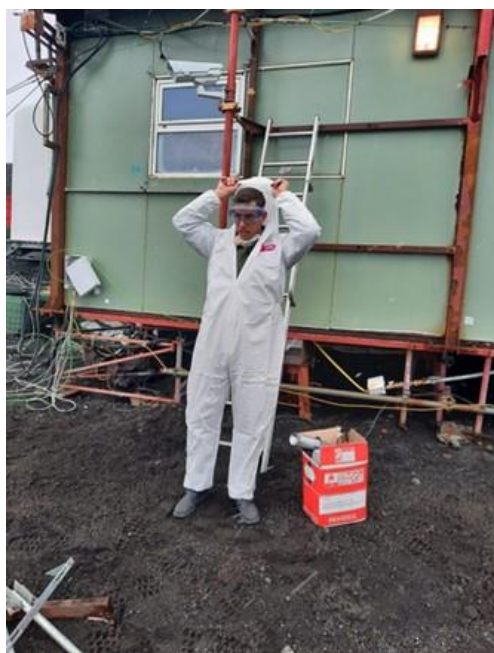
Preparación con el EPI y de la zona de trabajo para evitar derrames
