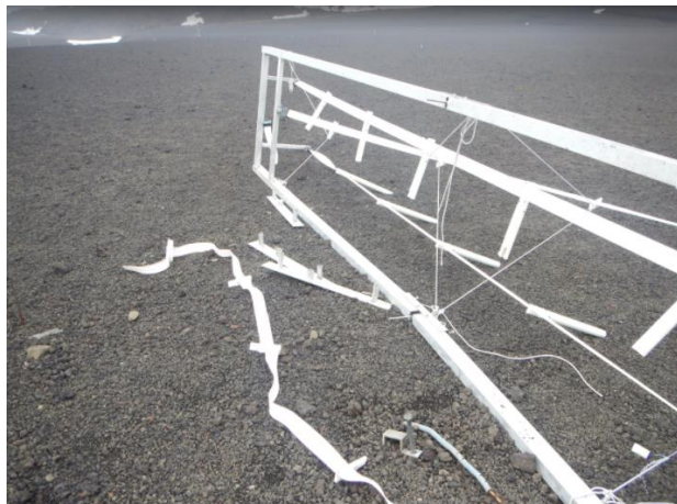
Daños producidos por el viento en una de las estaciones
