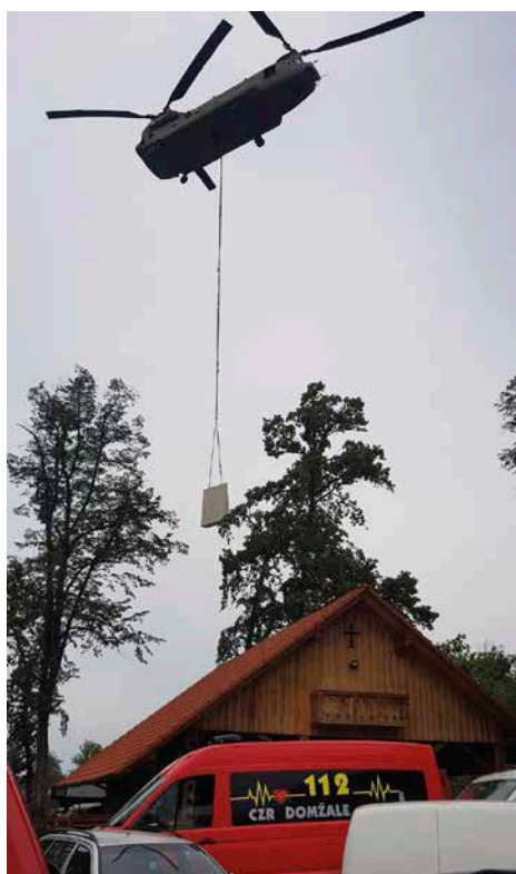
Construcción dique de contención
