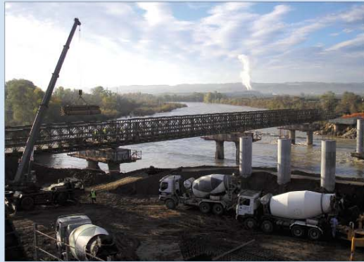
El RPEI nº 12 colaboró con la población con la instalación de varios puentes
