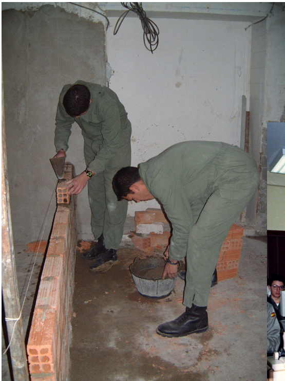
Trabajos de albañilería realizados por alumnos de Construcción y Obras
