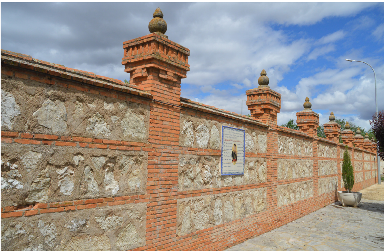
Muro del acuartelamiento que actualmente continúa conservando las pellas flameantes originales
