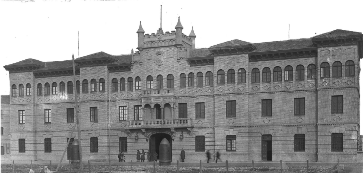
Fachada del Acuartelamiento Infante D. Jaime. Año 1927
