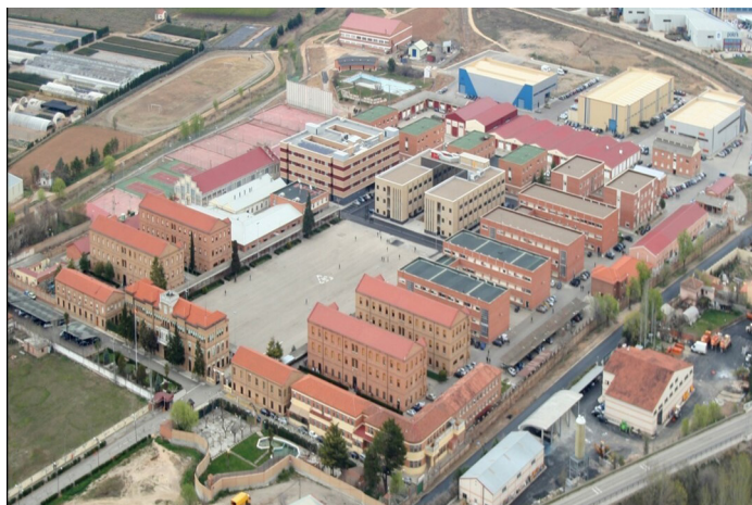
Imagen aérea de la Academia de Logística, donde se aprecian los edificios que se construyeron a partir de 2001 para integrar las enseñanzas que se impartían en el IPE n.º 1 y en la ELET. Las obras se desarrollaron por fases y no finalizaron hasta 2007
