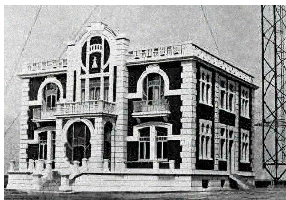
Edificio principal de la estación. Fuente: Memorial de Ingenieros del Ejército.
