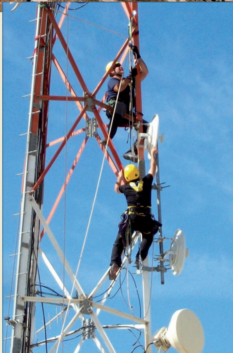
La base “Miguel de Cervantes” (arriba) ha modernizado sus transmisiones. Trabajos de montaje en altura de los nuevos radioenlaces (abajo)
