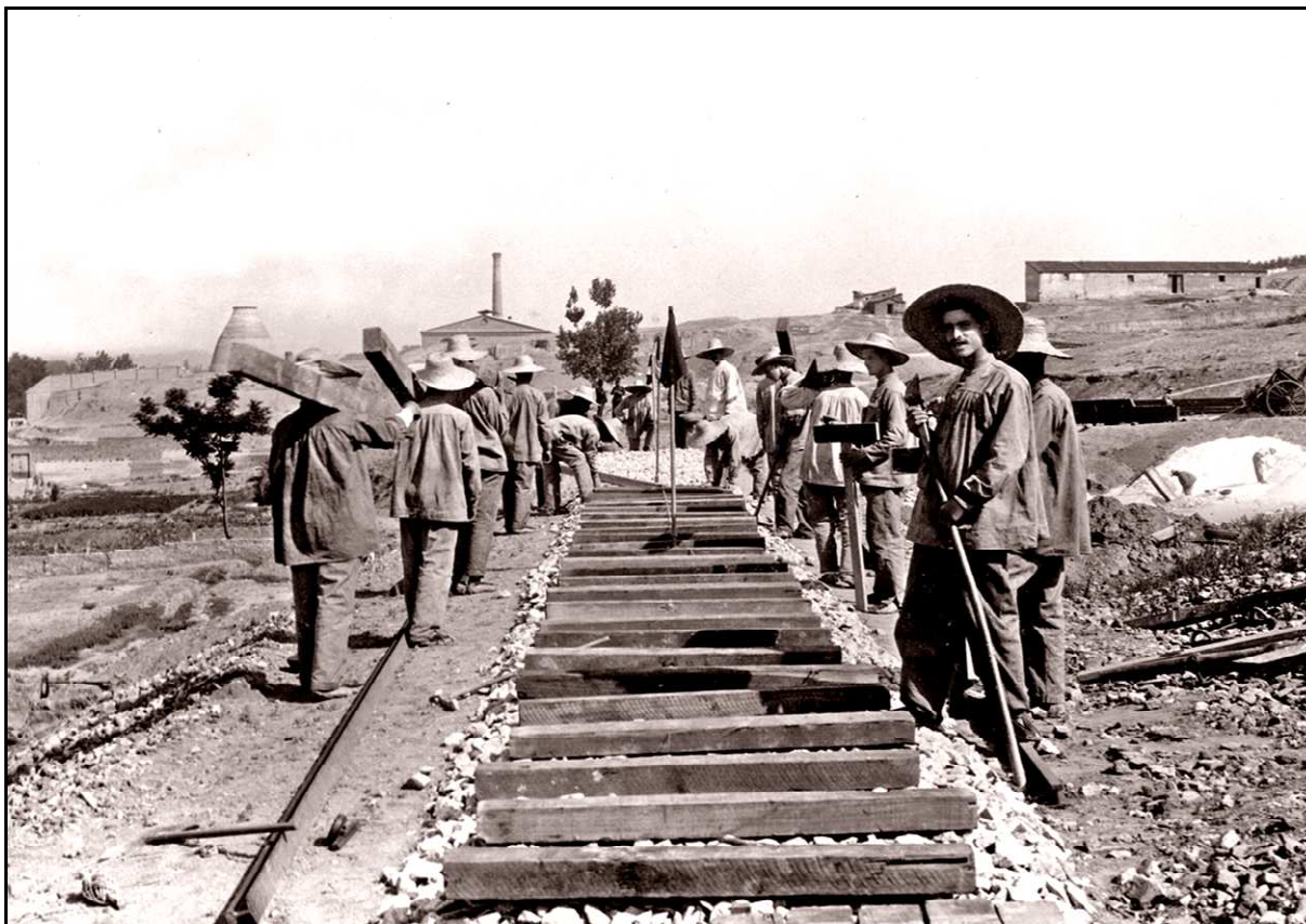
Prácticas de tendido de vías por parte de efectivos militares.
