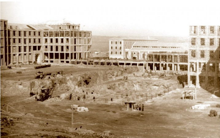
Obras de cimentación
