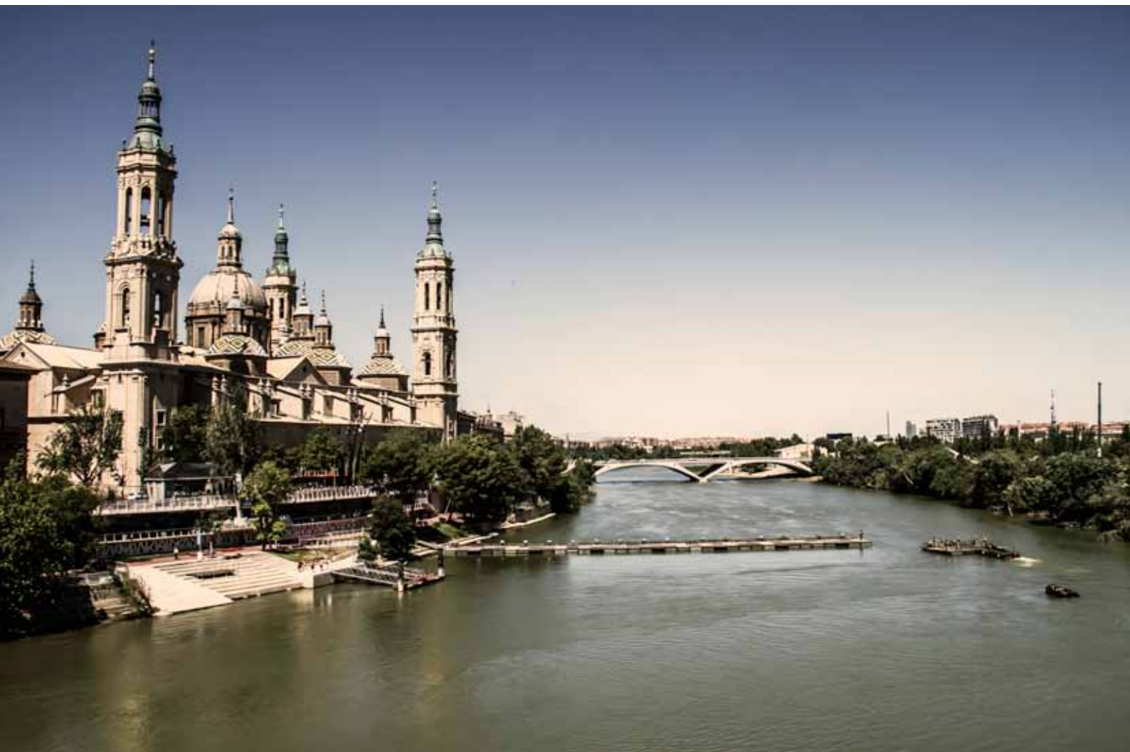
Tendido de un puente sobre el río Ebro, frente a la Basílica del Pilar de Zaragoza
