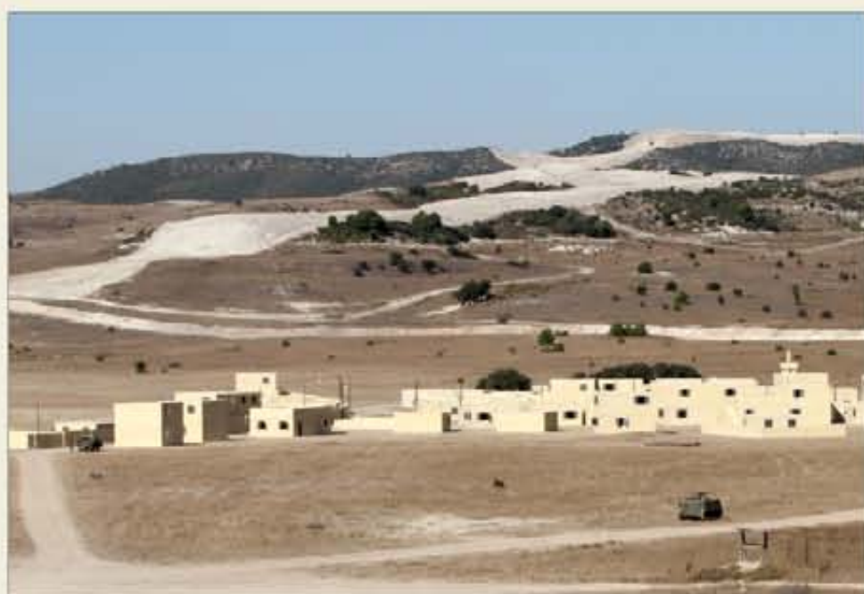
Nuevas construcciones en la zona de combate en población de Casas Altas
