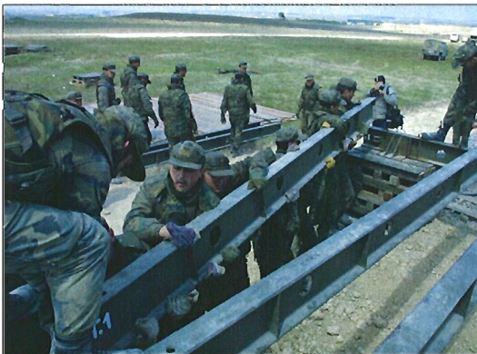
El puente Mabey se montó para salvar una brecha de 26 metros
