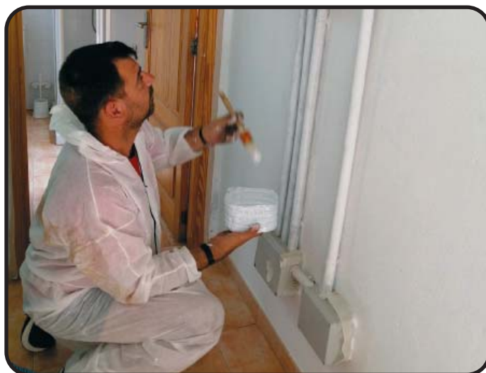
Realizando actividades de mantenimiento de instalaciones. (Fotografía: RI 47)
