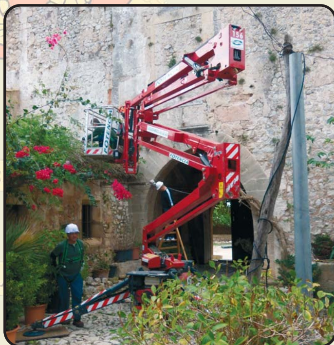
Trabajos en Santa Eulalia. (Fotografía: Col. Moreno)
