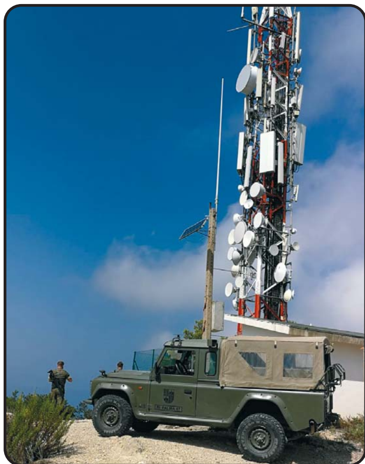
En vigilancia en las antenas de Sant Joan (Fotografía: OCP COMGEBAL)
