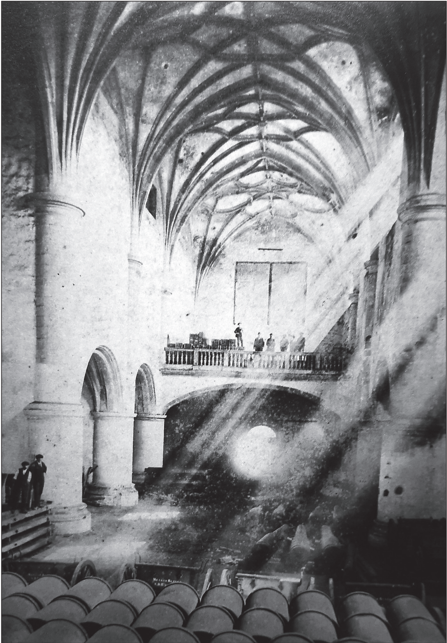
“Iglesia del Convento de San Telmo. San Sebastián 1894”. Interior de la antigua iglesia utilizado como Parque de artillería. Leopoldo Ducloux. STM F-002390.
