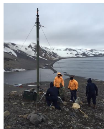
Montaje de relé
