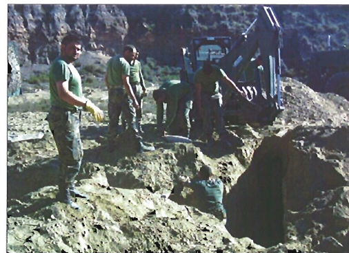
Excavación de una trinchera de acceso a un puesto de mando enterrado
