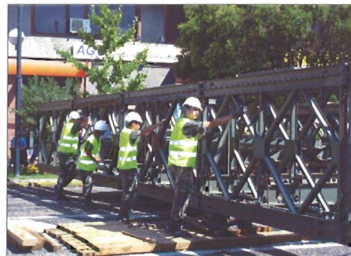
Los ingenieros montaron un puente tipo Bailey DSR
