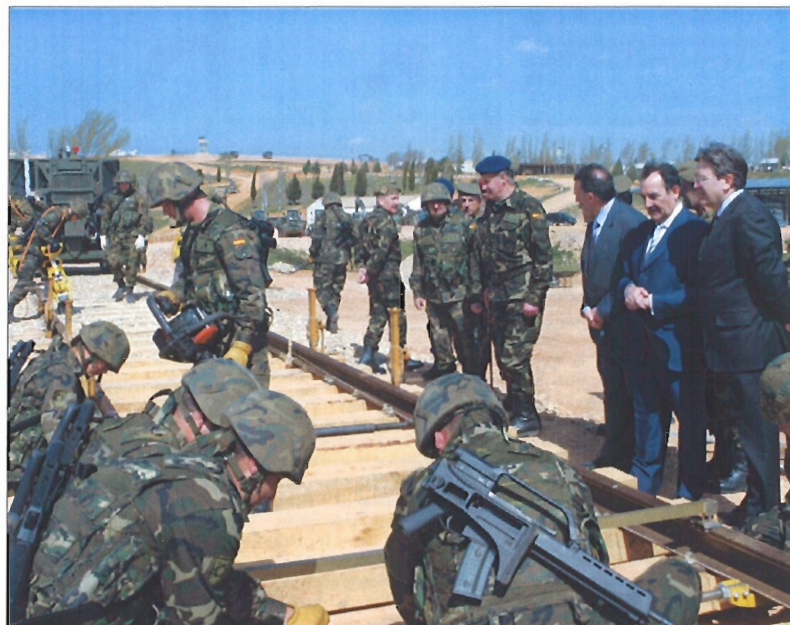
El personal de ferrocarriles construyó un tramo de vía ante la atenta mirada de Su Majestad y el resto de autoridades
