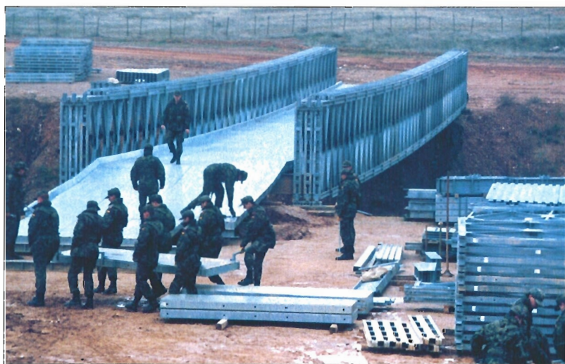
El Mabey, puente ligero y resistente, puede ser montado en 13 horas
