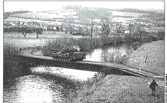
Este puente, de origen alemán, está construido con materiales de aluminio
