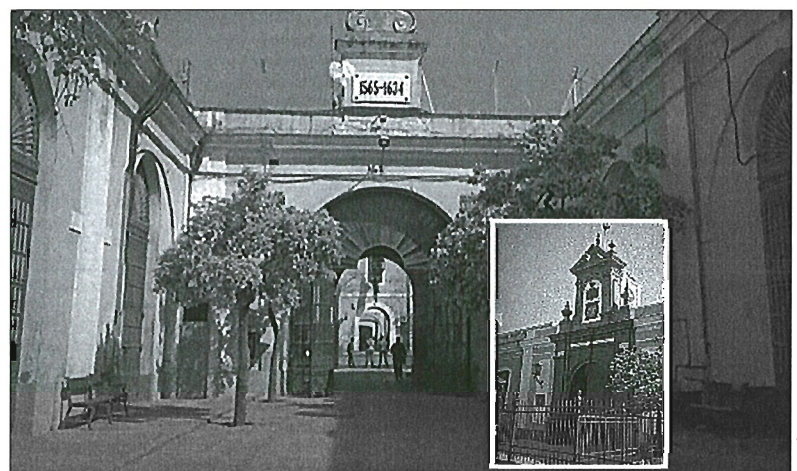
La Fábrica de Artillería comenzó a ser construida a principios del siglo XVIII.
