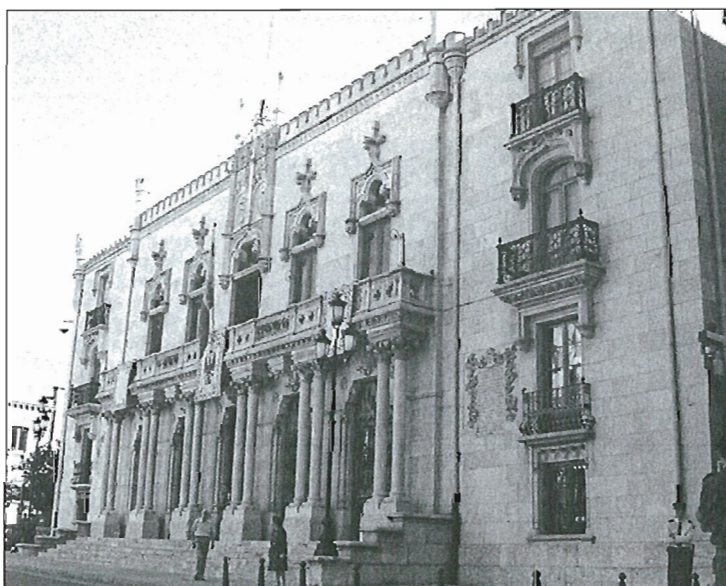
Antigua Capitanía de Burgos, nueva sede de la Inspección General de Movilización, cuyo mando ha asumido recientemente el teniente general Muñoz Manero.
