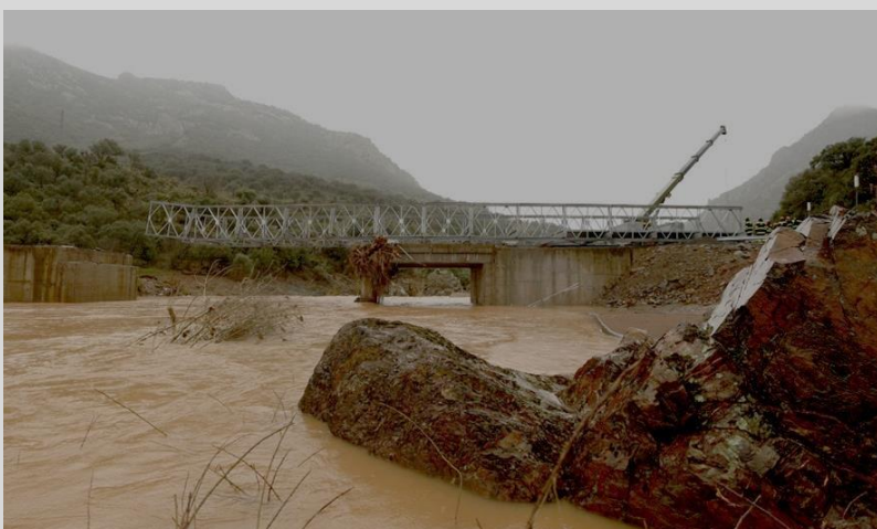
Puente Mabey sobre el río Fresnedá. Montaje UME
