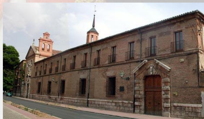
ESTADO ACTUAL DE LA 1ª ACADEMIA DE INGENIEROS EN ALCALÁ DE HENARES
