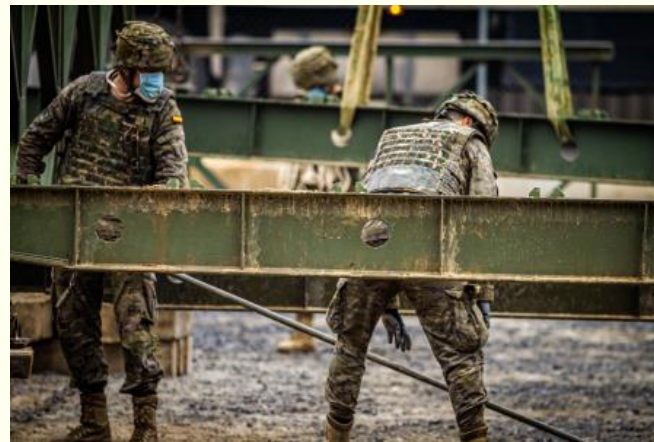
Tendido de puente Bailey
