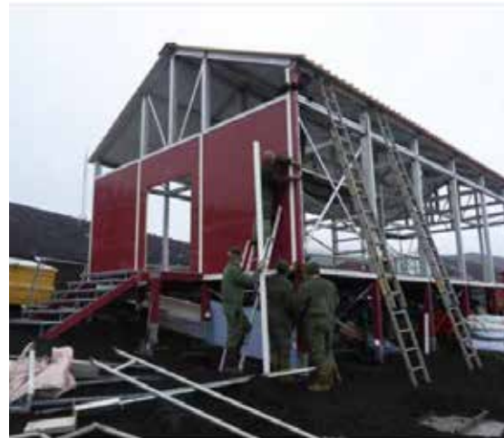
Construcción del módulo almacén. Diario de operaciones CA 2016-2017. Isla Decepción
