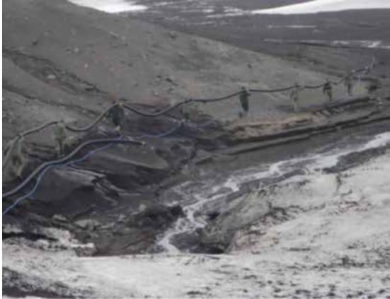
Despliegue y tendido de la tubería calefactada. Diario de operaciones CA 2015-2016. Isla Decepción
