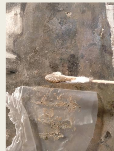
Eliminación de repintes
