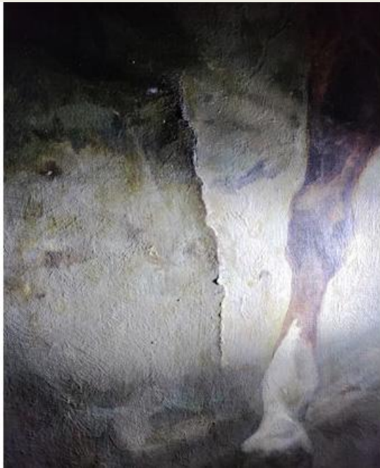
Deformación con cresta de rotura
