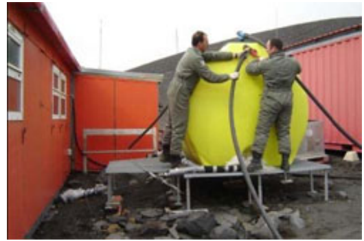
Rebosadero del depósito
