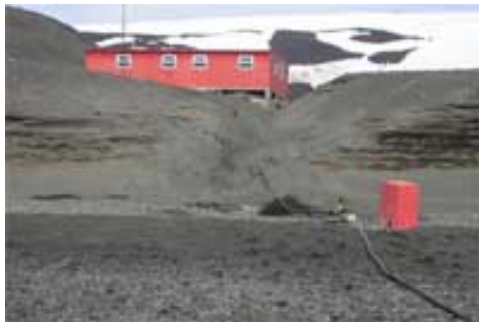
Conducto de agua salda
