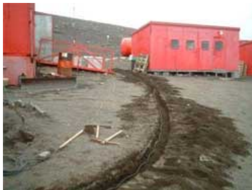
Tendido de cables.
