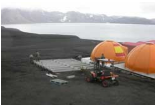
Instalación de la plataforma del iglú
