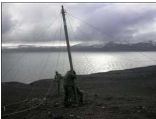
Retirada de la antena Delta Loop
