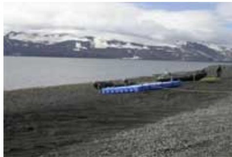
Trabajos para el fondeo
