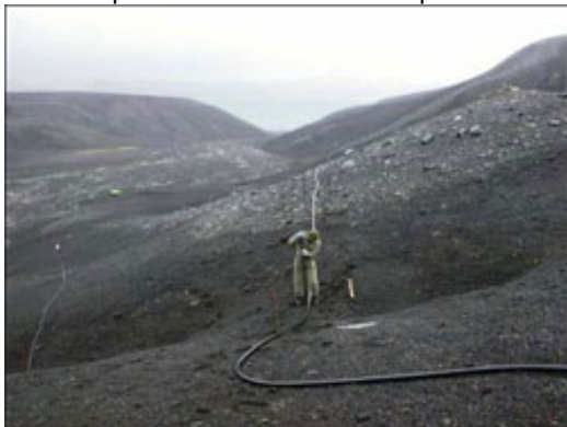
Revisión de la tubería de agua
