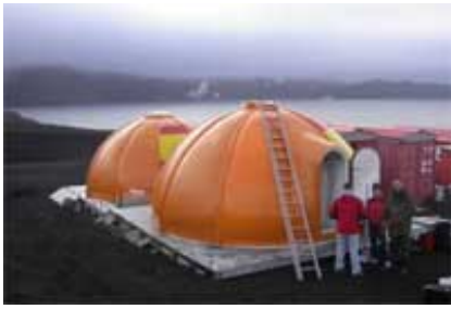
Trabajos en iglú
