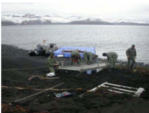
Retirada de la rampa
