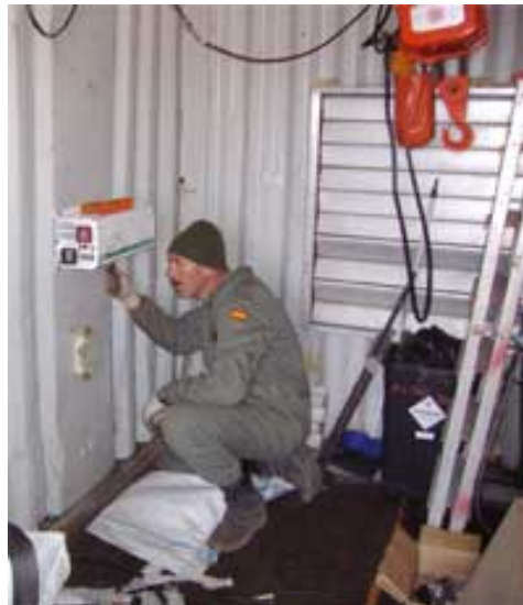
Cableando el proyecto de acumulación
