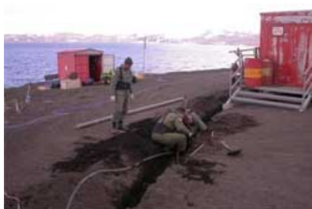
Trabajos en la tubería de agua
