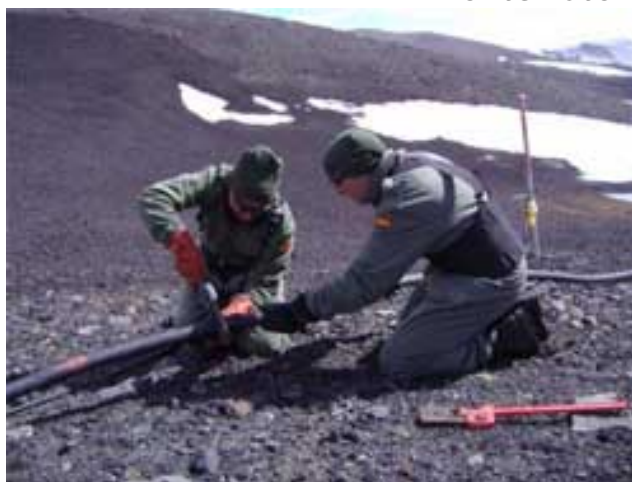
Trabajos en la bomba de agua
