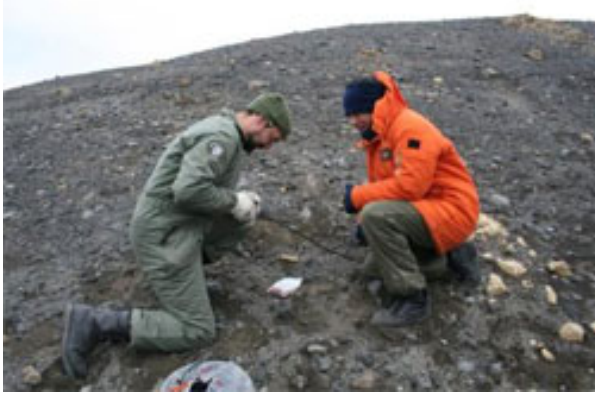
Tendido de cable (oficial español y responsable argentino)
