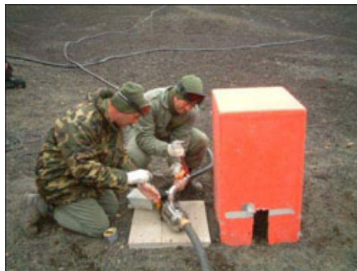
Instalación en la bomba
