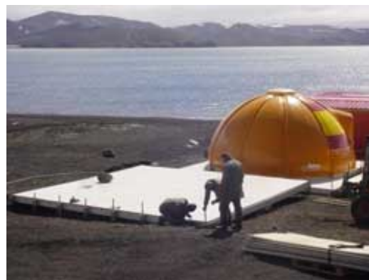
Instalación de la plataforma del iglú
