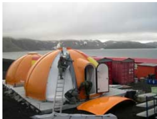
Trabajos en el iglú
