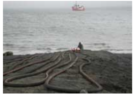
Preparando la manguera de combustible
